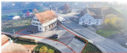
Umbauprojekt, 8254 Basadingen, ID1
